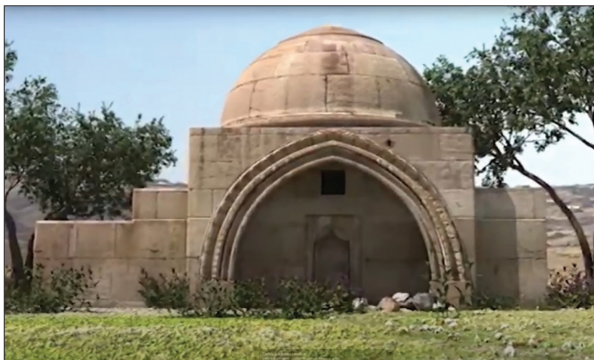
Şərifan kəndindəki sərdabə
